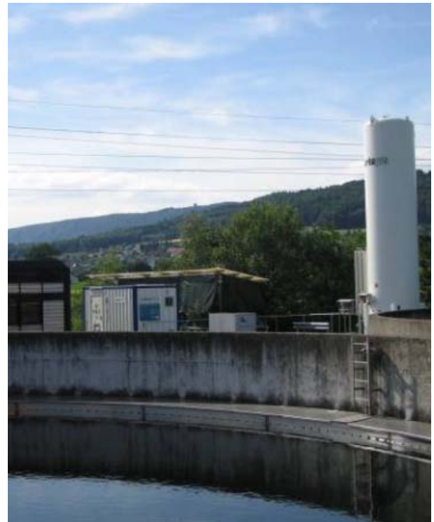
Kläranlage Regensdorf [Abegglen et al. 2009]
