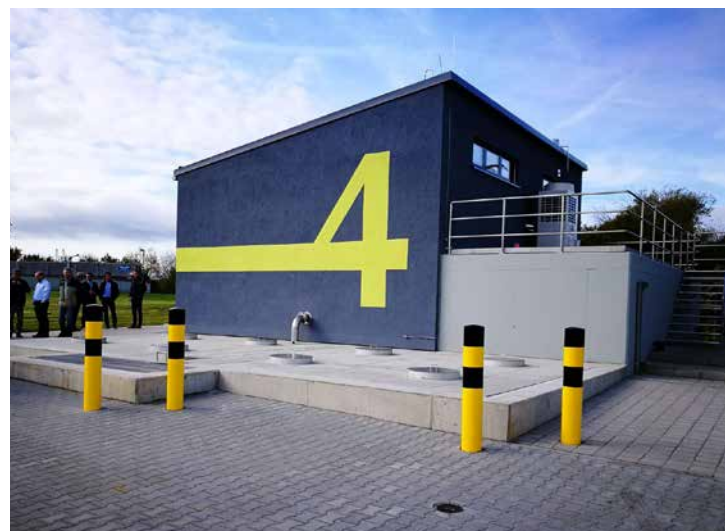
Bild 4 Erste bayerische Pilotanlage (KA Weissenburg): Ozonung mit nachgeschalteter Filtration mittels GAK-Filter Quelle: Nordic Water
