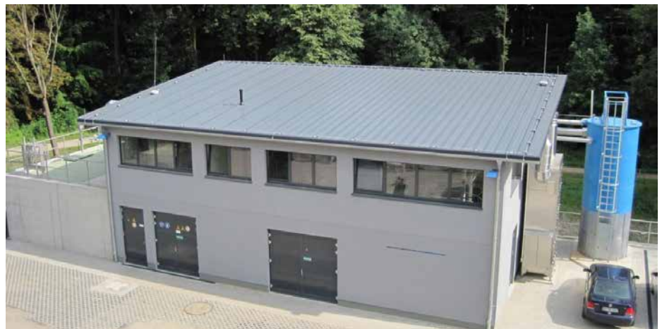
Bild 1 Spurenstoffe dezentral entfernt: Das Projekt „PILLS“ am Marienhospital Gelsenkirchen
